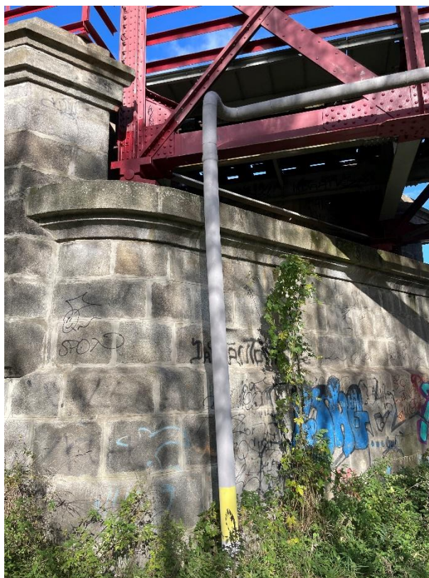
Obrázek 3 – VTL plynovod (aktivně chráněný) vedený po mostní konstrukci
